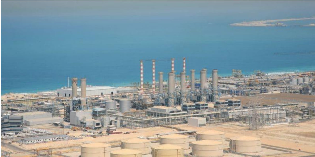
Figuur 9: De door wind aangedreven ontziltinginstallatie in Dakhla (Takouleu J.-M., 2022)
