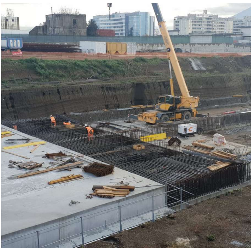
Realizzazione solettone di copertura Gall. Casalnuovo
