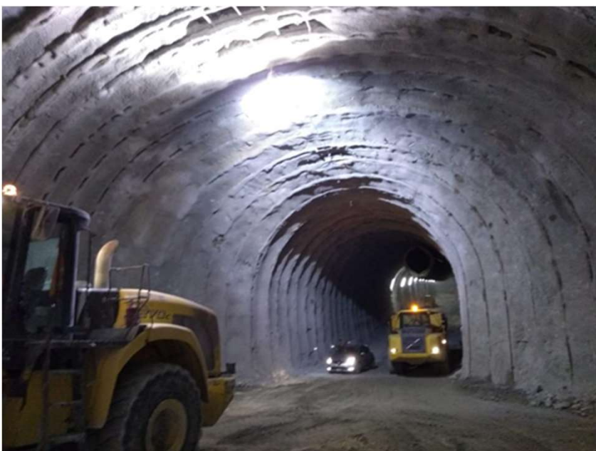
Fasi di scavo galleria Monte Aglio
